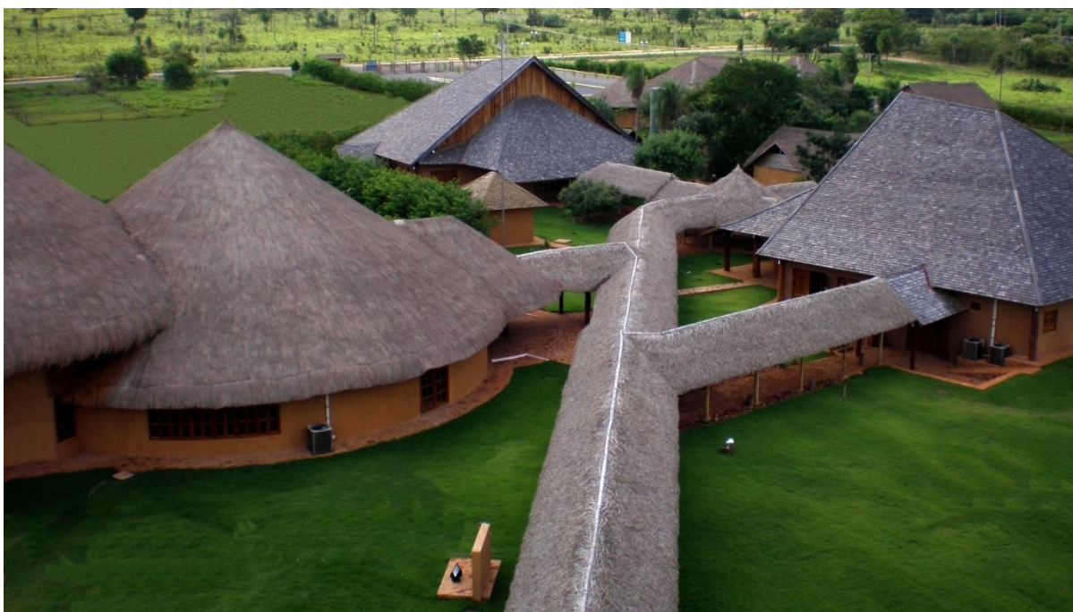
Visão geral com a rodovia ao fundo.
