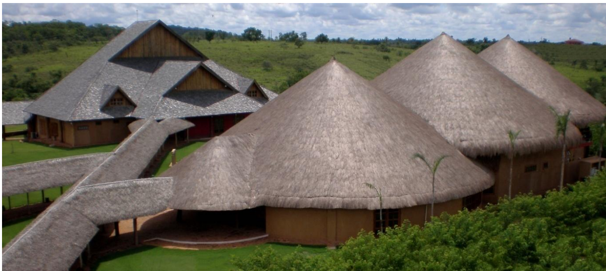
Visão geral do Auditório Guaicurus (ao fundo) e do Espaço Guató.
